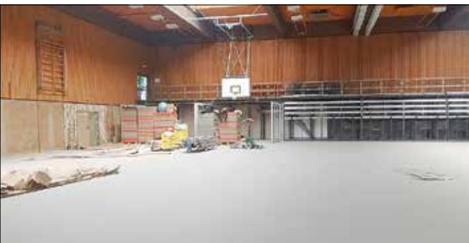
Bauliche Maßnahmen am Schulstandort Höhr-Grenzhausen.
