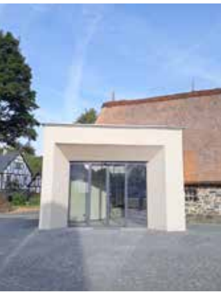
Eingang des Landschaftsmuseums nach Umbau.
