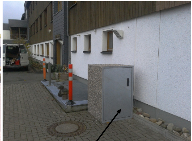
Probekühlschrank an der Gebäudenordseite in einer Waschbetonbox
