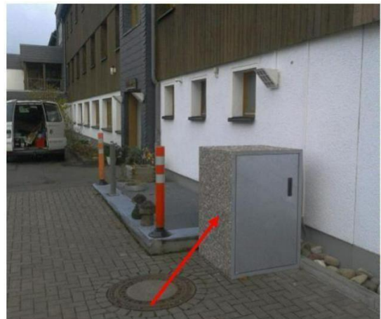
Probenkühlschrank an der Gebäudenordseite in einer Waschbetonbox
