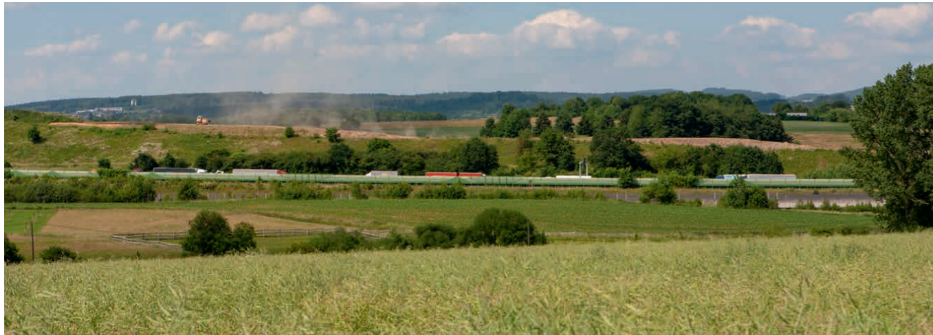
Lärmschutz an der A3 in der Nähe von Montabaur
