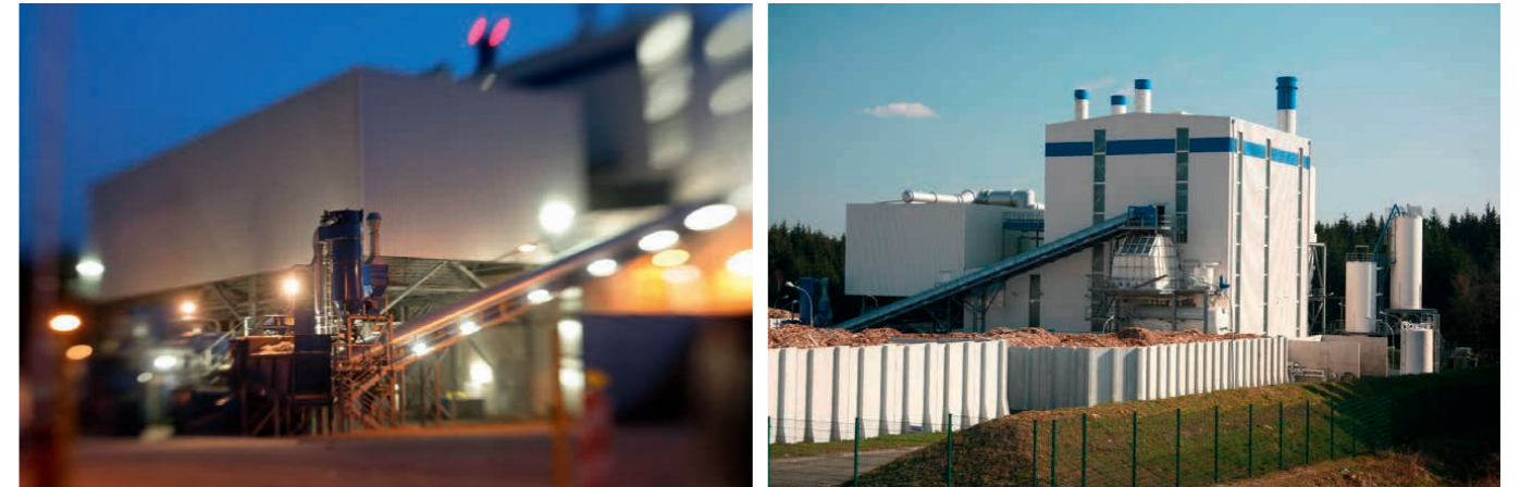
Heizkraftwerk Siegerland; Quelle: Biomasse Heizkraftwerk Siegerland GmbH und Co. KG
