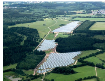
Solarparks Halbs und Hergenroth in der Verbandsgemeinde Westerburg; Quelle: Koch Gebäudetechnik
