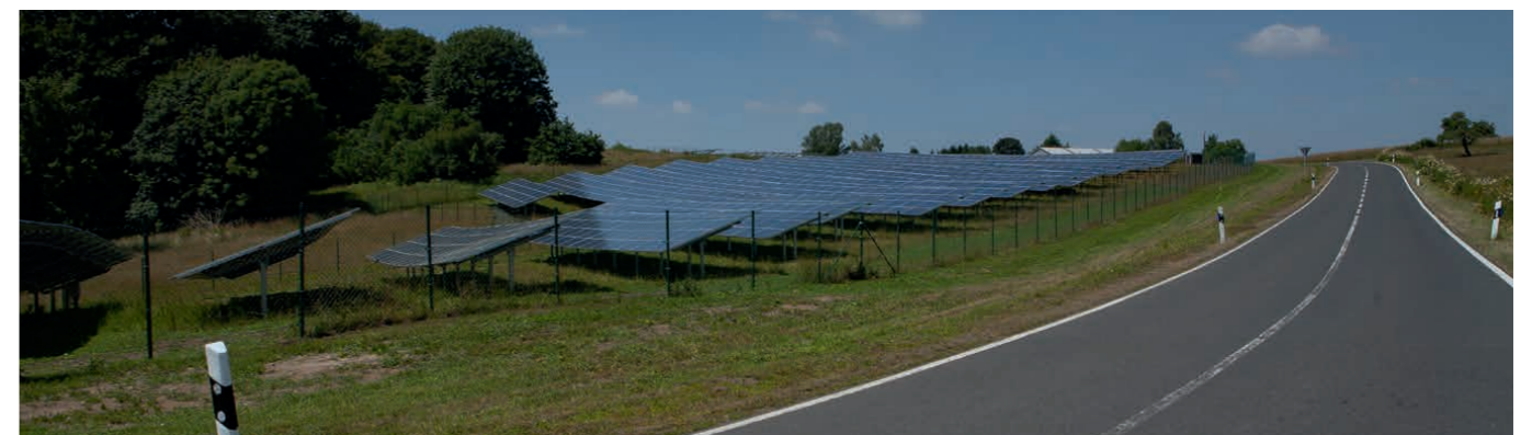
Solarpark bei Wölferlingen
