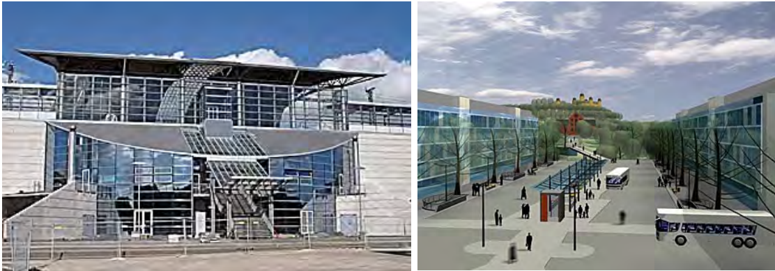
Abb. 4-1: ICE-RegioBahnhof, links Empfangsgebäude, rechts ZOB mit Blick vom Empfangsgebäude in Richtung Stadt [Quelle: www.ice-park-montabaur.de ]
